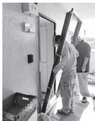
新しいドア枠の取付け
